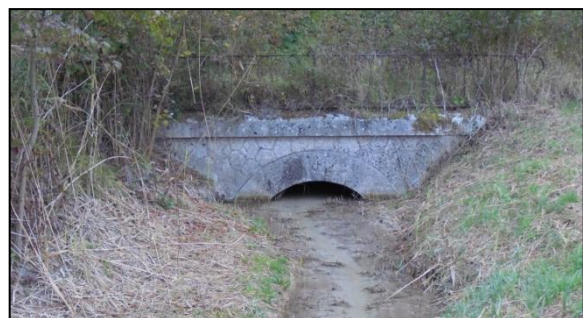
Photographie 12. Section d'écoulement faible au niveau du pont situé à l'amont du site d'étude.
