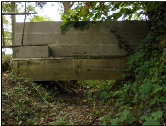
Photographie 15. Obstacle à l'écoulement des eaux à l'entrée du fossé de chez Madame Massa
