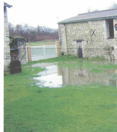
6 l'eau remonte progressivement dans la cour pour arriver hauteur de bottes
