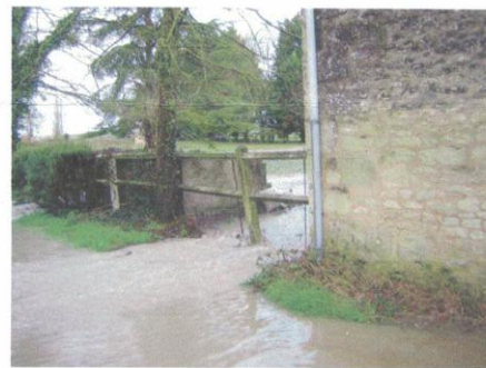
4 eau sortant de chez le voisin en amont
